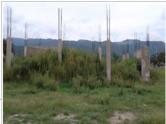
F3: Fachada posterior
